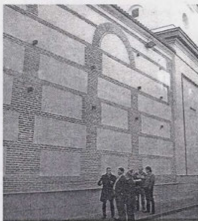
Aspecto de la fachada lateral tras la conclusión de los trabajos. A. S.
