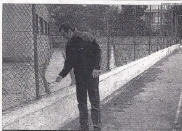
La valla, de alambre trenzado, está rota y los padres temen que sus hijos se lastimen
