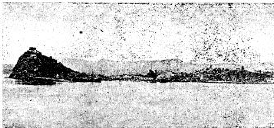
Vista general del Puerto a principios de su construcción (1866)
